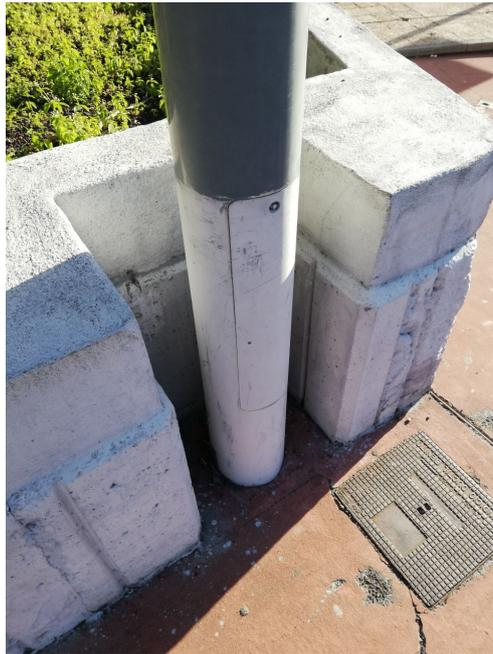
No obstante, para respetar la banda de acceso establecida en la normativa de accesibilidad aplicable, el muro exterior de la acera debe presentar continuidad en una altura mínima de 0,2m, por lo que la base del soporte de la luminaria debe estar al menos a 0,2m del suelo.
