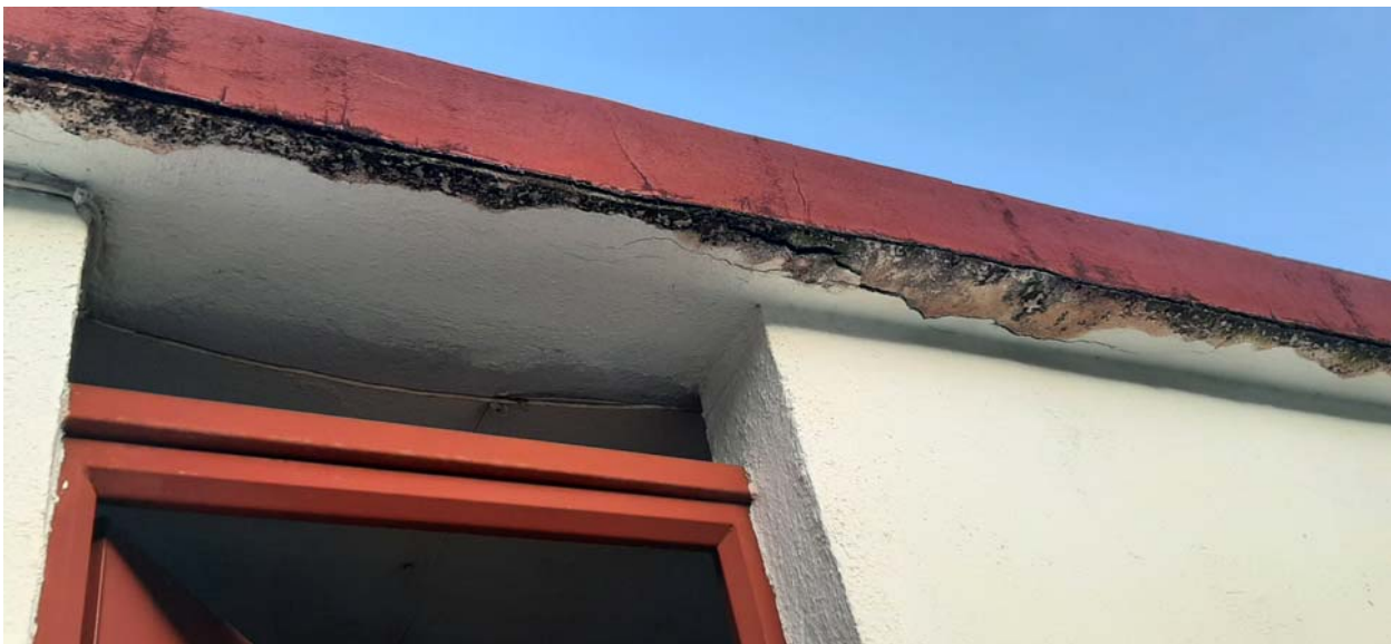
Fotografía nº1: Bloque 3. Losa de lavadero.
