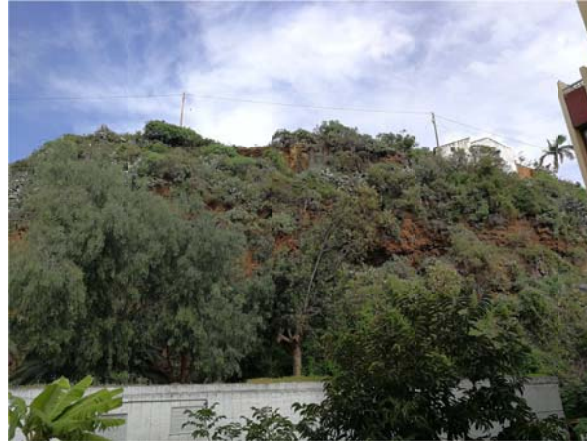
Fotografía n°10: Zona 3. Estabilización de taludes.
