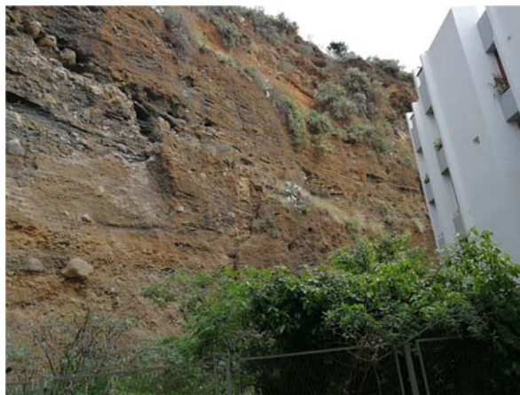
Fotografía nº7: Zona 1. Estabilización de taludes.
