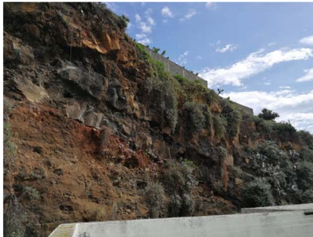
Fotografía nº8: Zona 2. Estabilización de taludes.
