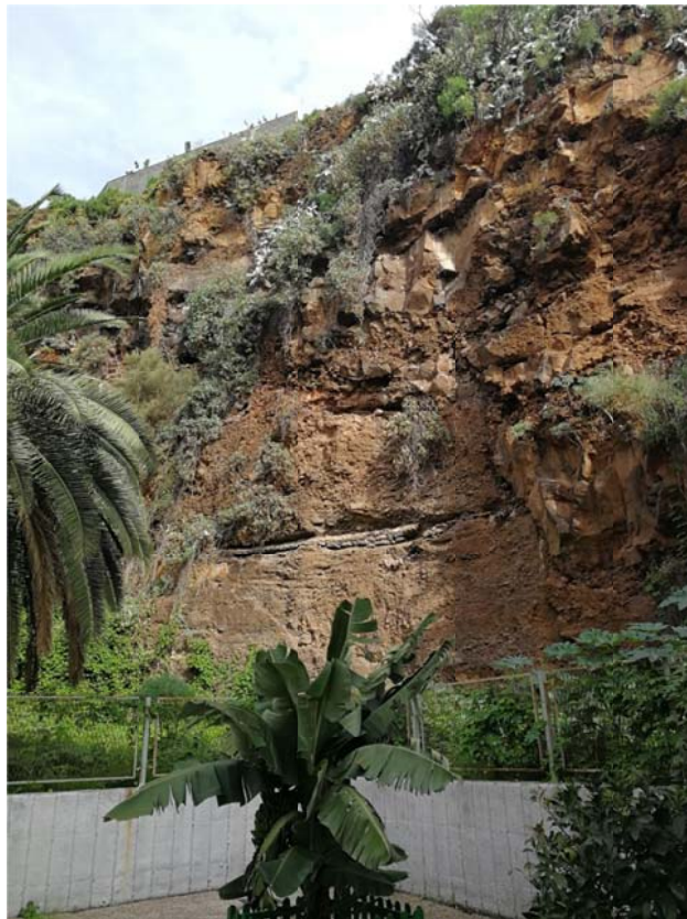
Fotografía nº9: Zona 2. Estabilización de taludes.
