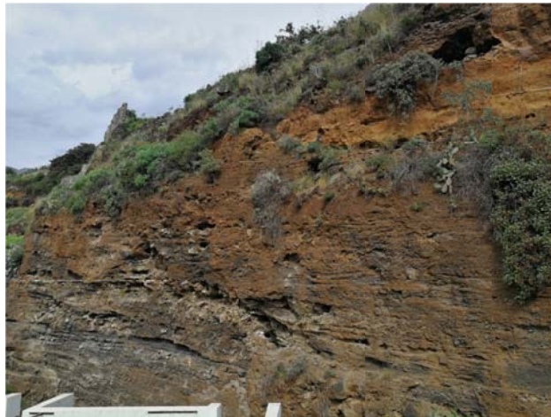
Fotografía nº6: Zona 1. Estabilización de taludes.
