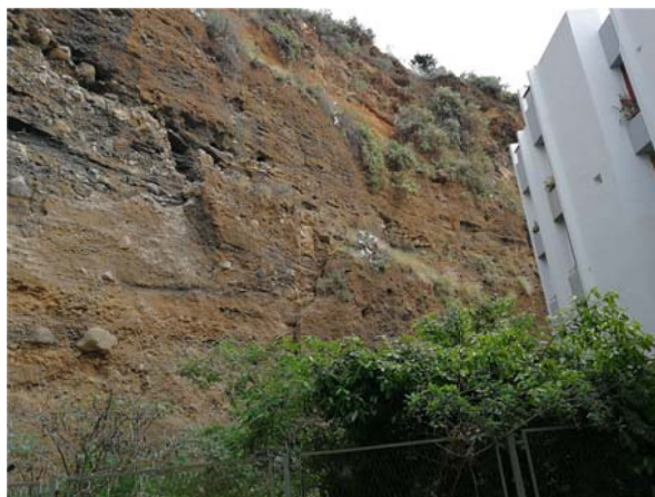
Zona 1. Estabilización de taludes.
