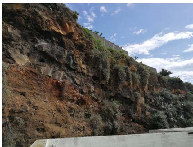
Zona 2. Estabilización de taludes.
