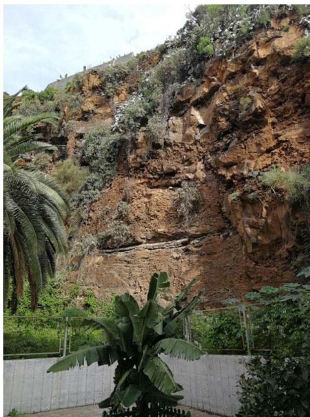
Zona 2. Estabilización de taludes.
