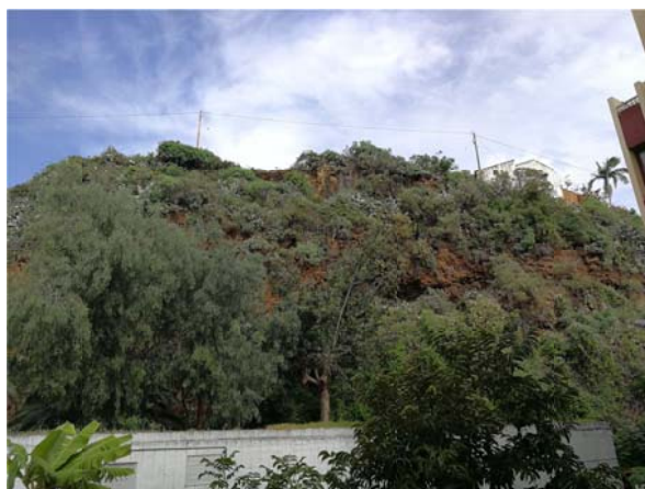
Zona 3. Estabilización de taludes.
