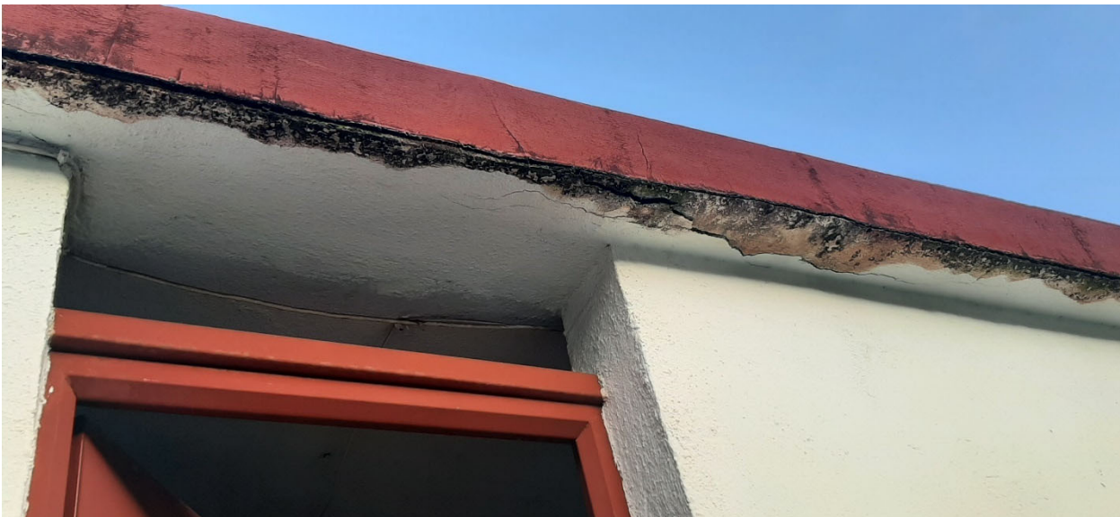
Fotografía nº1: Bloque 3. Losa de lavadero.
